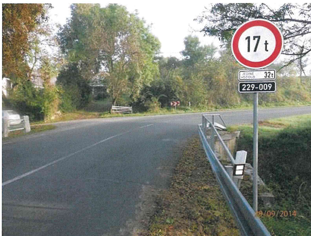
II/229 VŠESULOV, MOST EV.Č. 229-009
